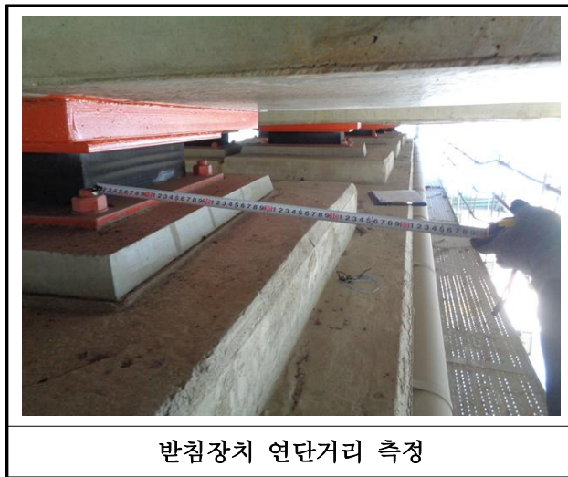
【사진 8.3.14】 교량받침장치 연단거리측정
