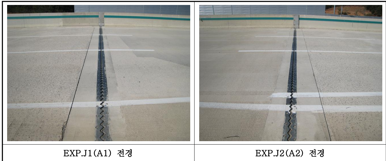
【사진 8.3.16】 신축이음장치 전경
