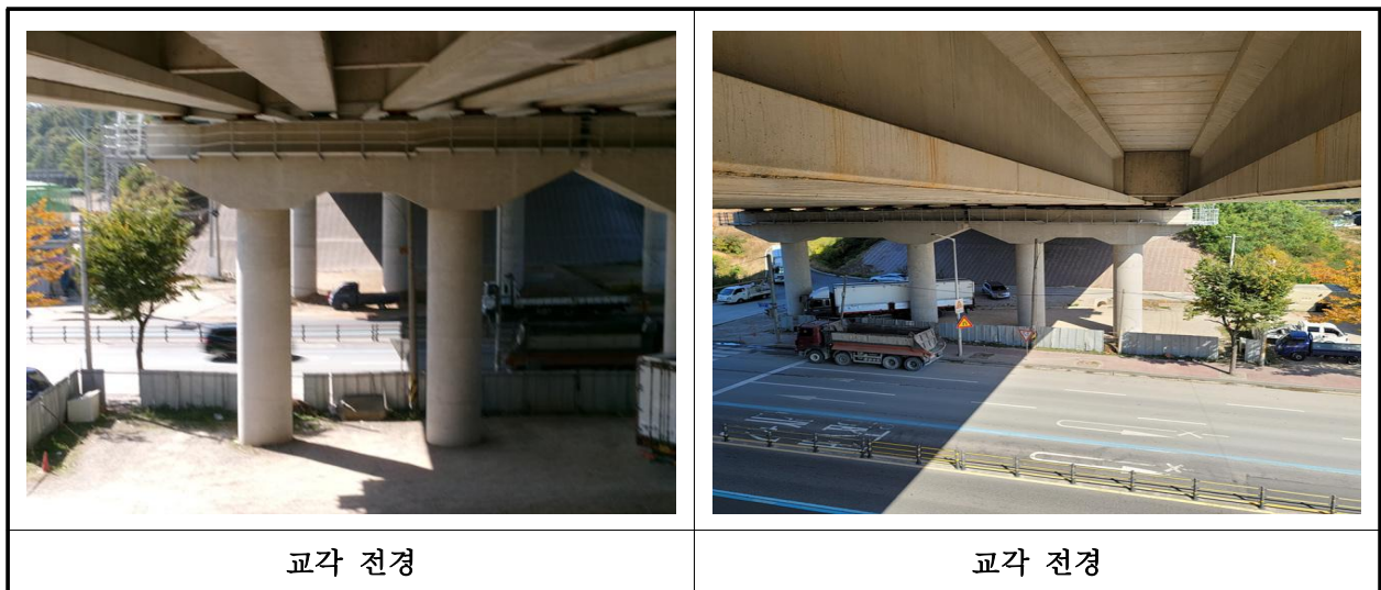
【사진 8.3.10】 교각 전경
