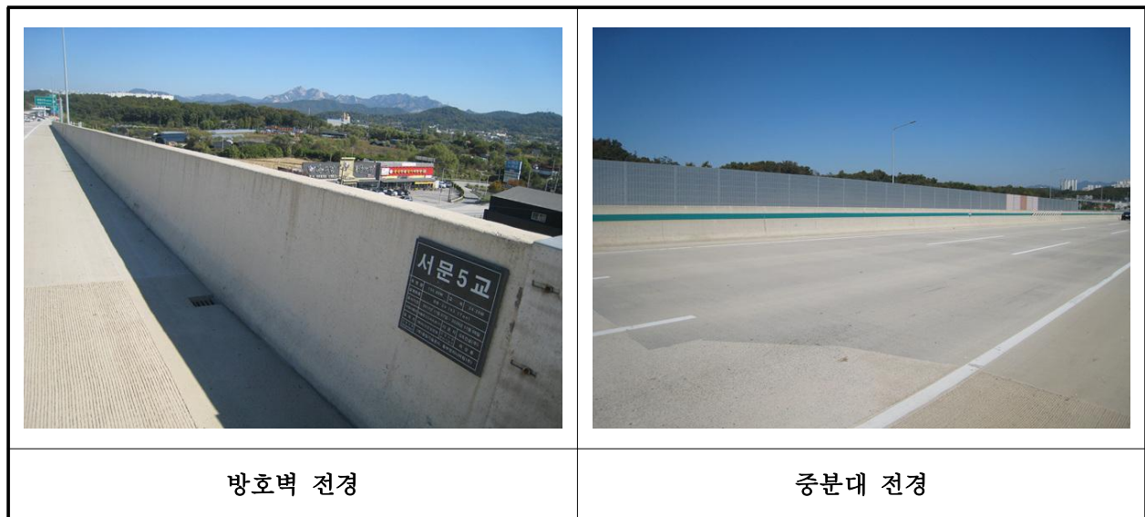
【사진 8.3.23】 방호벽 및 중앙분리대 전경
