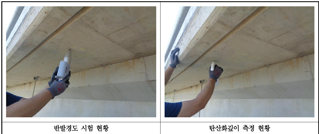
【사진 8.4.1】 콘크리트 내구성조사 현황
