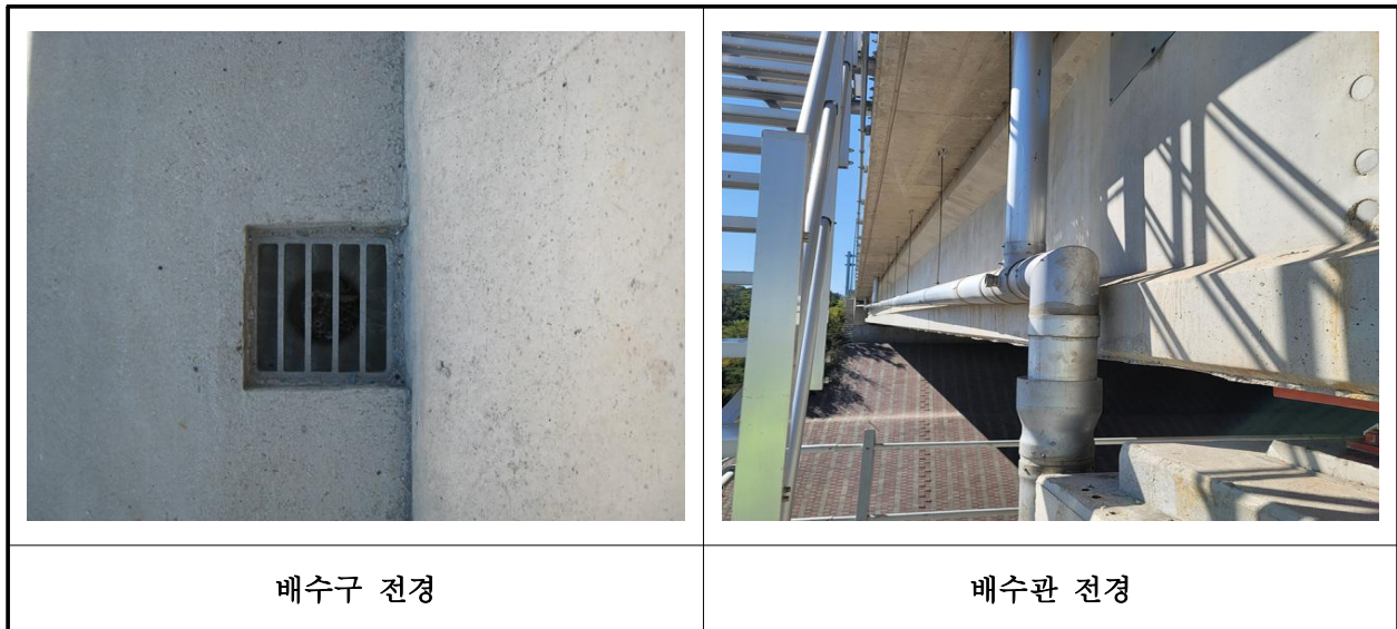
【사진 8.3.21】 배수시설 전경
