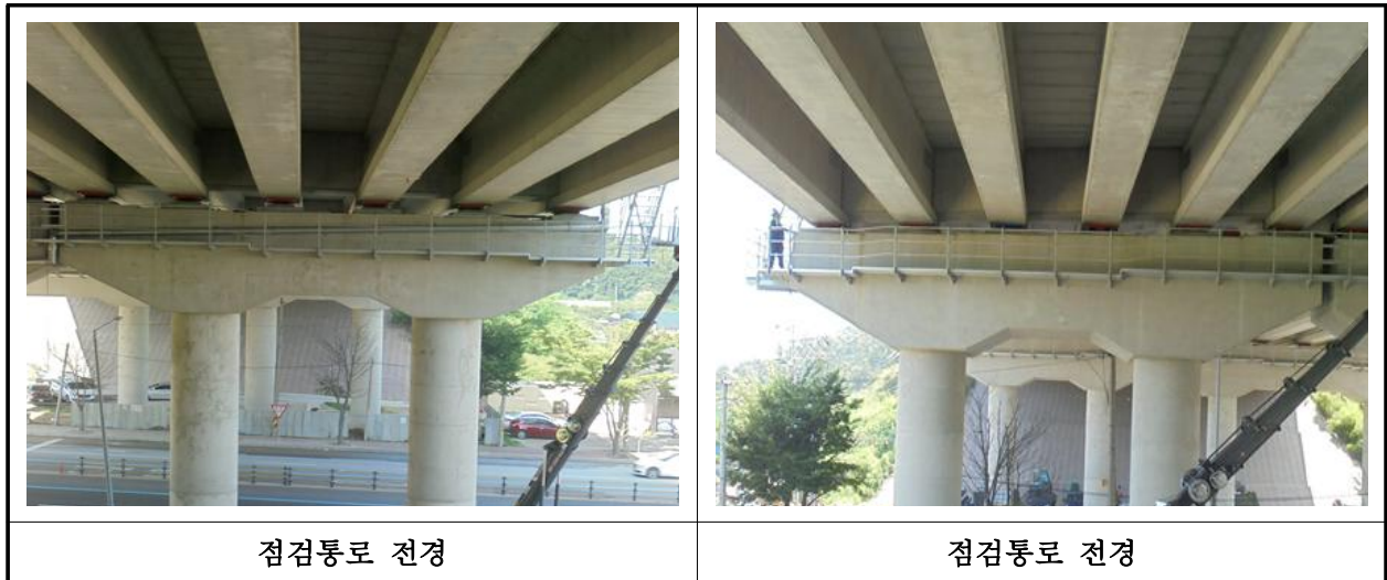
【사진 8.3.25】 교량 점검시설 전경
