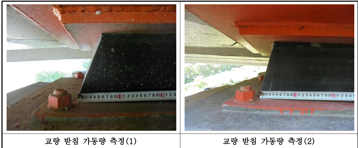
【사진 8.3.15】 교량받침 이동량 측정
