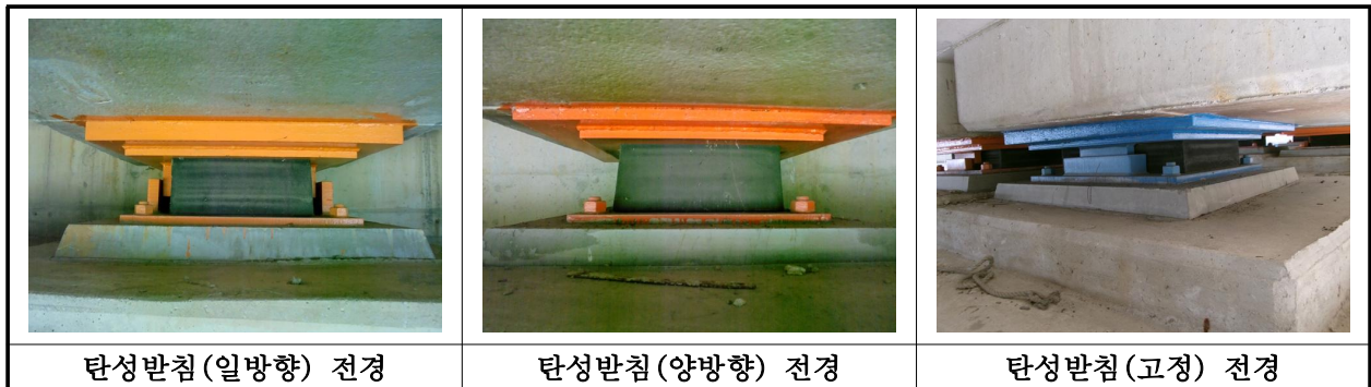
【사진 8.3.12】 교량받침 전경
