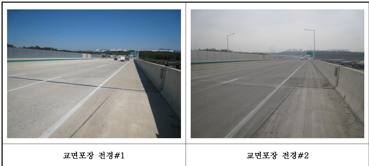
【사진 8.3.19】 교면포장 전경
